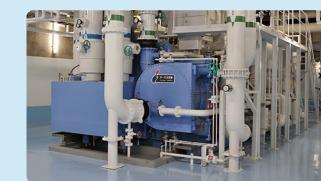
サンシャインシティの地下にあるエネルギークリーラーで冷水や蒸気をつくり、冷暖房を行うエネルギーとして、地域の様々な建物に安定供給しています。高効率運転により省エネルギーとCO<sub>2</sub>排出抑制を実現しています。
